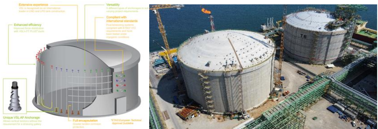
Fig. 1.4: LNG tank project by DAOR E&C Co., Ltd.
